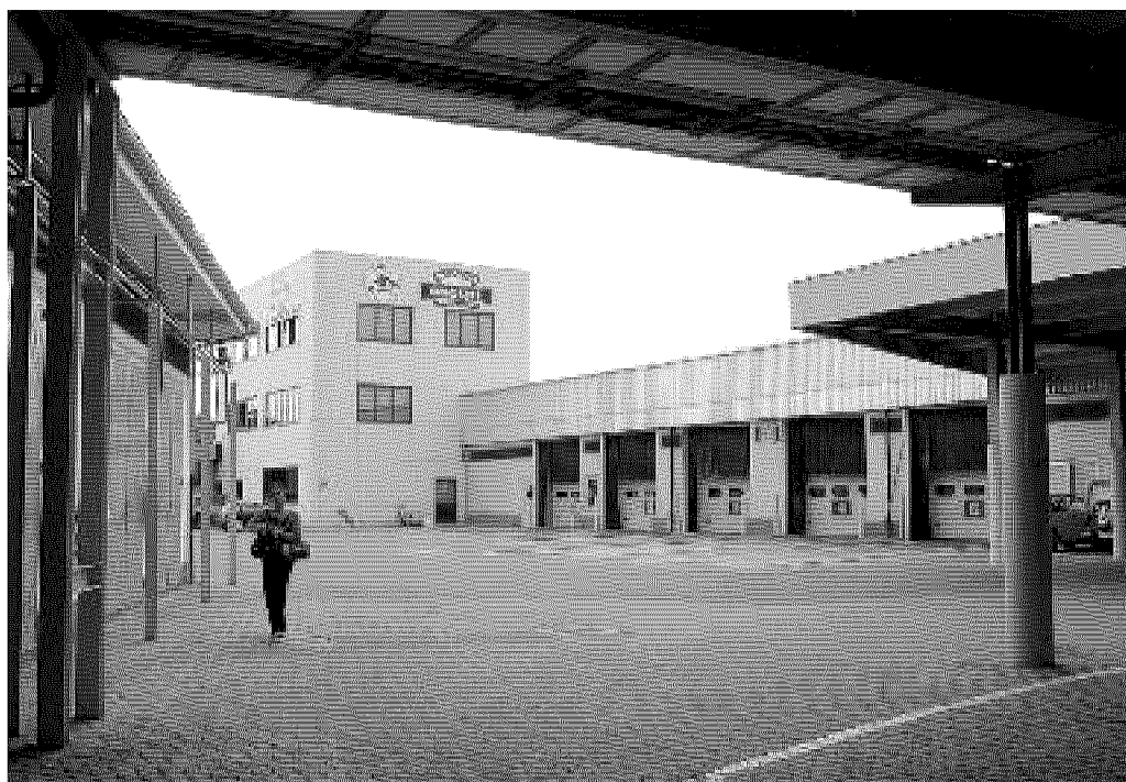
Lo stabilimento Inalpi di Moretta trasforma il latte in polvere destinato all'alimentazione umana
